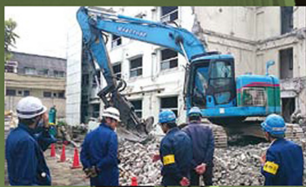
▲解体工事現場 安全パトロール
