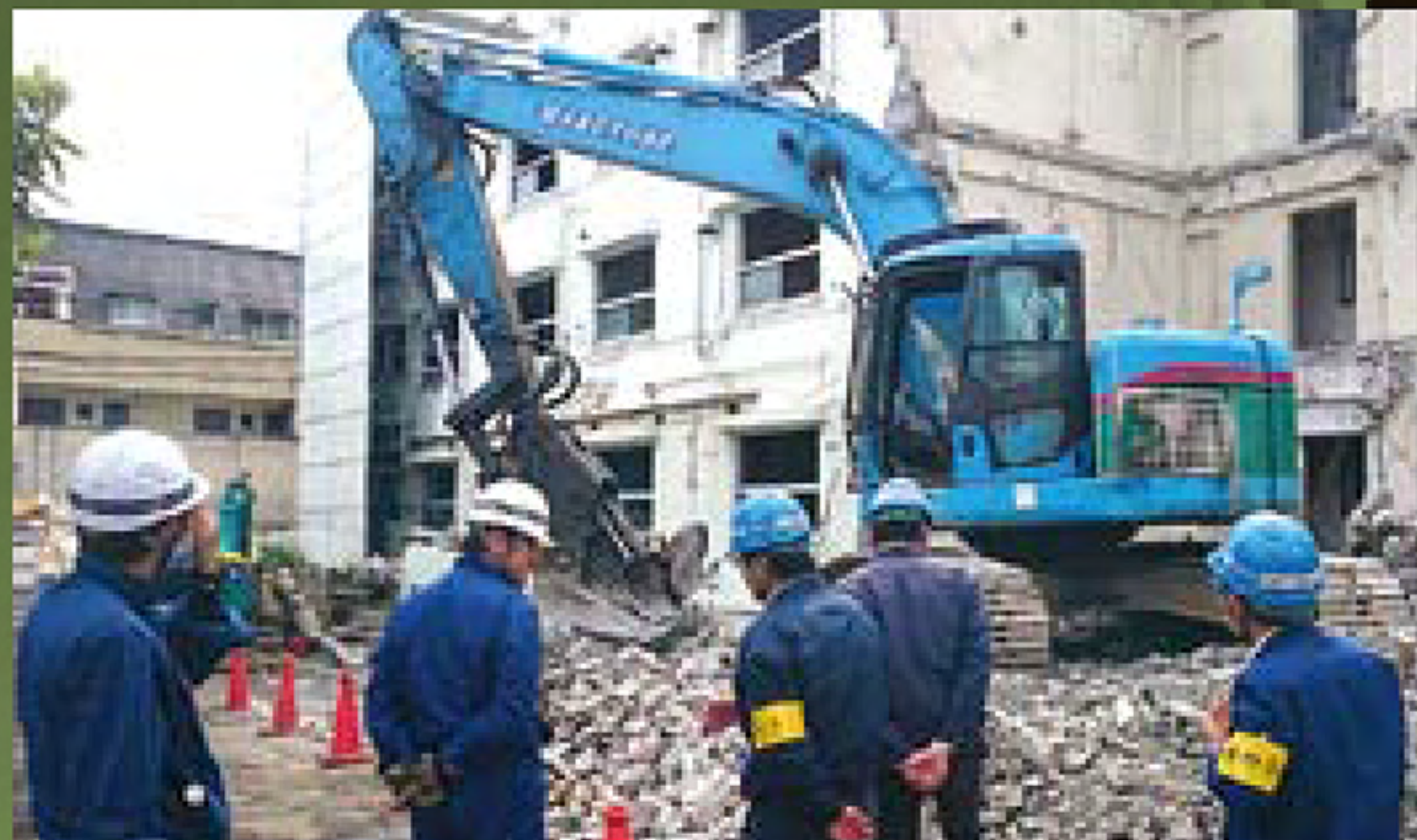
▲解体工事現場 安全パトロール
